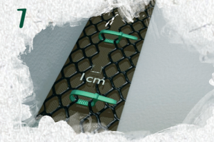
7 Juntar las piezas de malla SOLDRAIN (con grapas FIXSOL/HOOKSOL o bridas BRIDFIX) dejando 1 cm entre ambas para absorber posibles dilataciones
