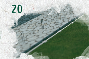
20 Fijar el perímetro de la instalación con grapas cada 50 cm
