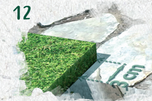
12 Cuando se corte, hay que dejar un sobrante de 3 cm para absorber posibles dilataciones
